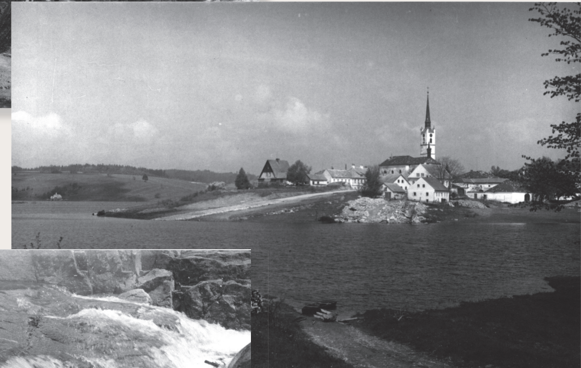
Obec Frymburk se vzdouvající se hladinou Lipenské vodní nádrže, foto Bohumil Červený, 1959
